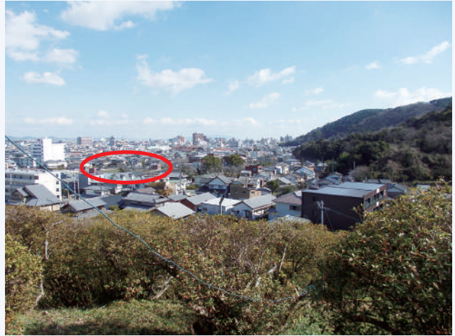
写真1 佐古配水場遠景
