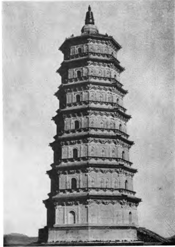
西方から見た白塔
